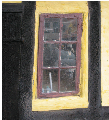
Til venstre: Sort træbjærefarve på bindingsværk. De små 'noprer' i overfladen bliver ikke bløde eller smitter af. Til højre: Sort stenkulstjære på bindingsværk. Denne er grovere i strukturen og bliver blød, smitter af og løber i stærk varme, f.eks. om sommeren. Foto: Anne Lindegaard.
