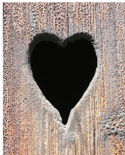
Ældre farvet træbjæ har en overflade som krokodilleskind. Foto: Arne Høi
