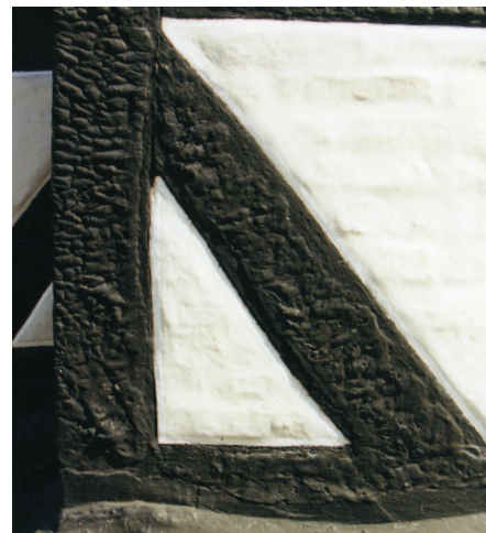
Til venstre: Sort træbjærefarve på bindingsværk. De små 'noprer' i overfladen bliver ikke bløde eller smitter af. Til højre: Sort stenkulstjære på bindingsværk. Denne er grovere i strukturen og bliver blød, smitter af og løber i stærk varme, f.eks. om sommeren. Foto: Anne Lindegaard.
