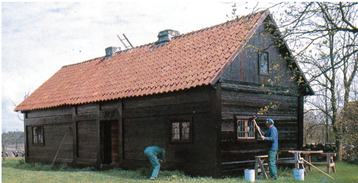
Træbjæring af laftehus på Gotland. Foto: John Kronborg Christensen.
