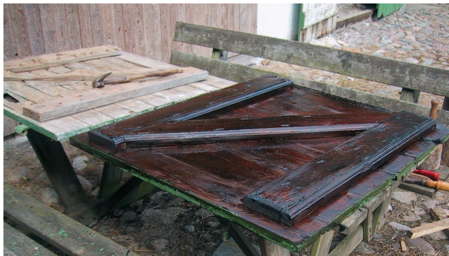
Regenerering af blødt træ med træbjære. Når træbjæren er hærde, bliver træet hårdt og vandafvisende igen.
